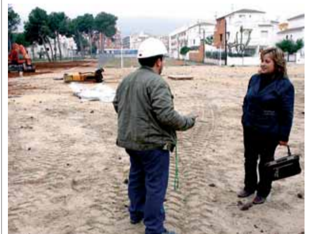
En marcha el nuevo colegio de Oropesa. Las obras del que será el segundo centro de Primaria de la localidad arrancaron ayer mismo. Para la construcción de la escuela, que albergará a unos 300 estudiantes, se seguirá el sistema de módulos prefabricados. ADN
